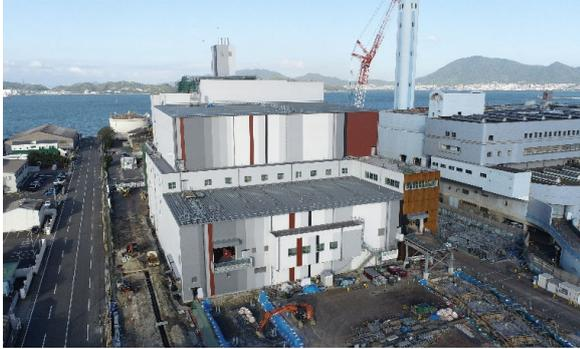
土木建築工事は段階的に内外装仕上げ・電気・設備各種工事を進行中。付属棟・外構工事進行中
